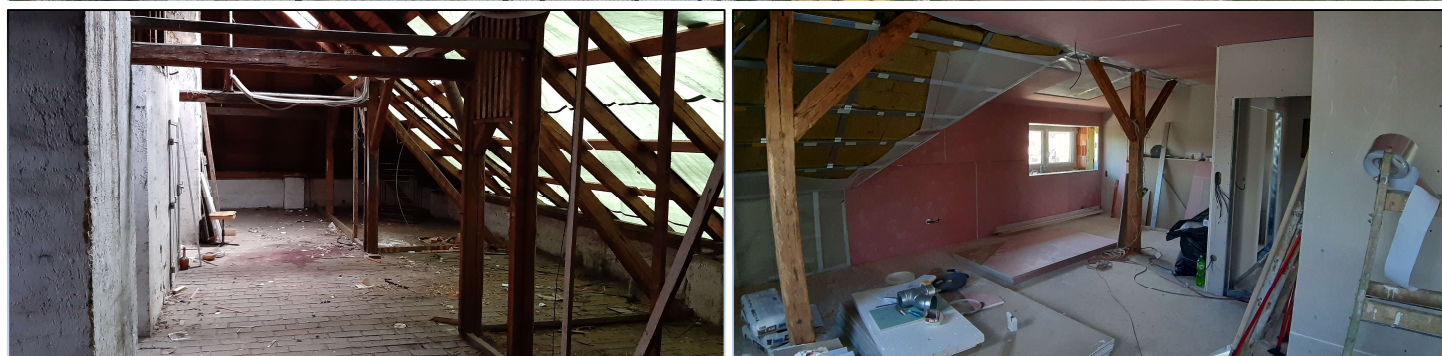
Výstavba sociálních bytů v budově obecního úřadu (březen-srpen 2020), foto: redakce
